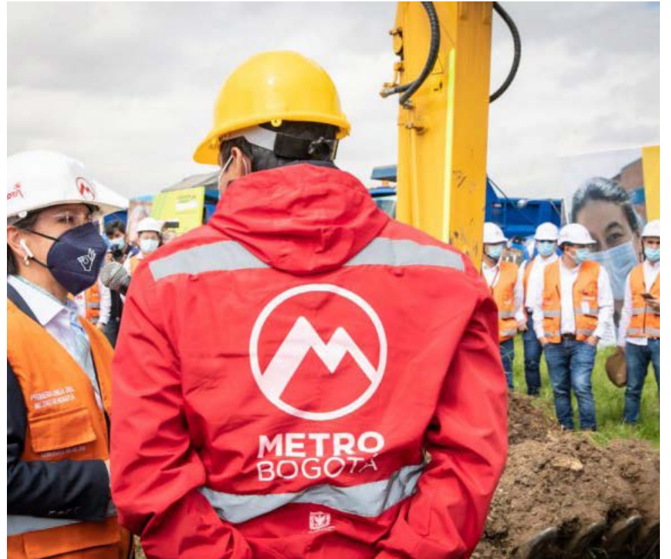
El primer informe que entrega para la parte técnica que inicia la construcción del Metro de Bogotá
