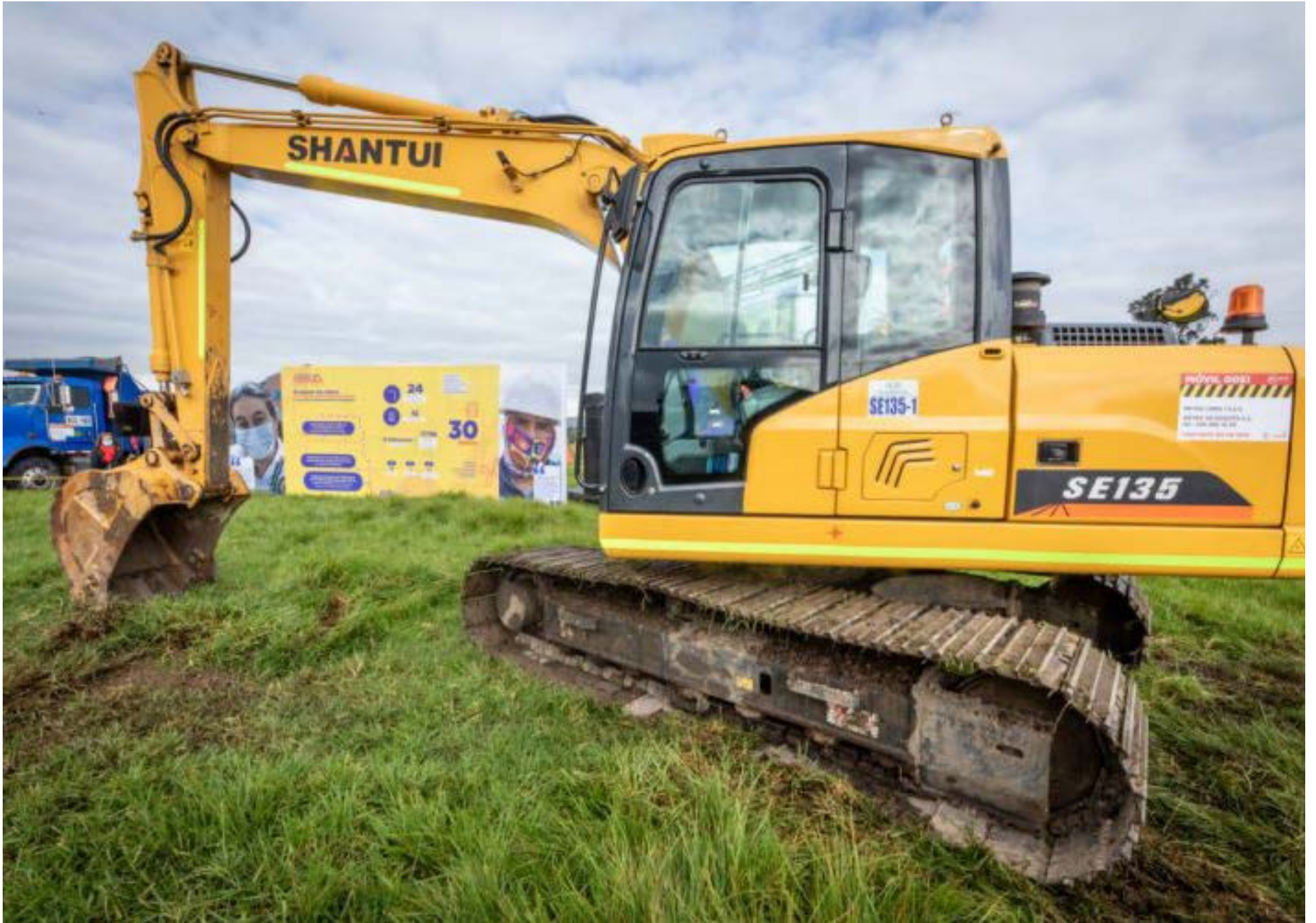
Se inicia la excavación
